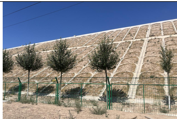
路基坡脚植树绿化
