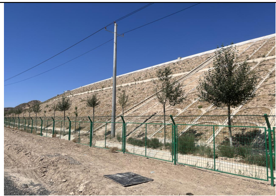
路基坡脚植树绿化
