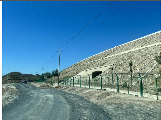
施工道路碎石铺压
