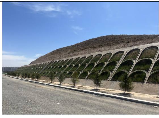
综合护坡内绿化
