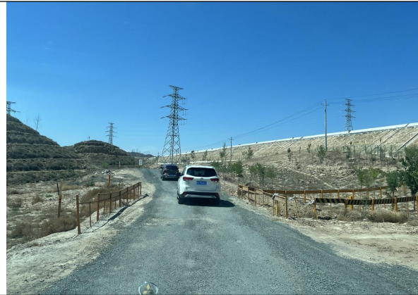
施工道路碎石铺压
