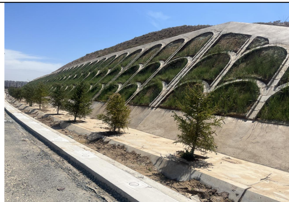
综合护坡内绿化
